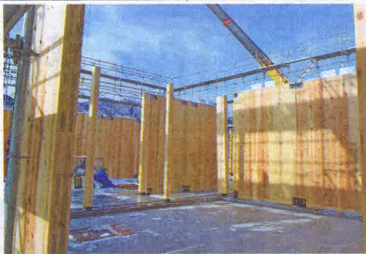
建築工事が進む三栄工業所の新社屋
